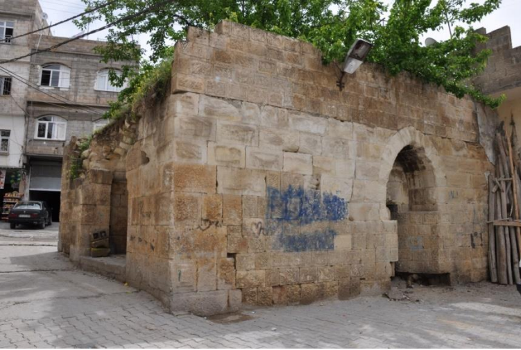
Fotoğraf 30. Meçan Kapısı – Arka Cephe, Kuzeybatı Köşesi
