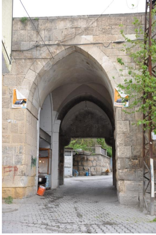
Fotoğraf 4. Batı Cephesi-Giriş Kısmı
