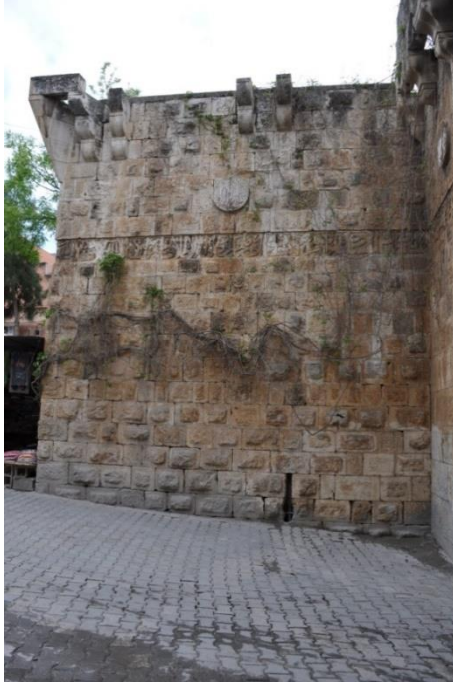
Fotoğraf 21. Asıl Giriş Kapısının Güney Tarafı
