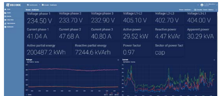
Slika 5. Očitane trenutne vrednosti napona, međufaznog napona, struja, aktivne i reaktivne snage sa mrežnog analizatora
