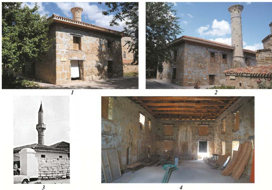
Рис. 6. Мечеть Шукурла-эфенди в Евпатории: 1 – вид с юго-запада; 2 – вид с юго-востока (фото 2019 г.); 3 – минарет до реставрационных работ 1986 г. (по В.А. Кутайсов, 2007); 4 – интерьер (фото автора 2019 г.)
