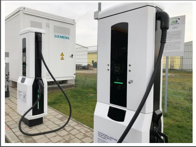
Şekil 4. Siemens 450 kW uydu sistem şarj istasyonu [24].
