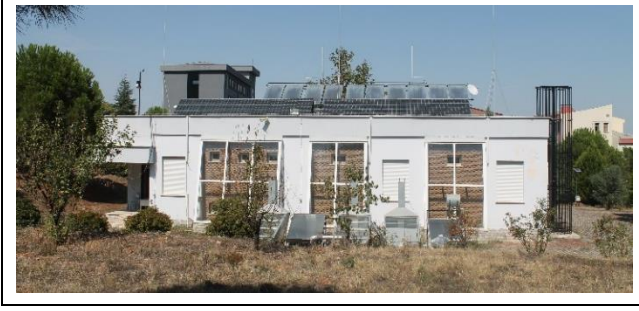
Şekil 5. Çatı montajlı fotovoltaik modüller. Figure 5. Rooftop mounted photovoltaic modules.
