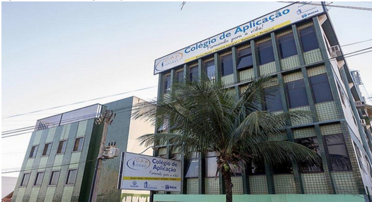
Figura 1. Fachada do Colégio de Aplicação
