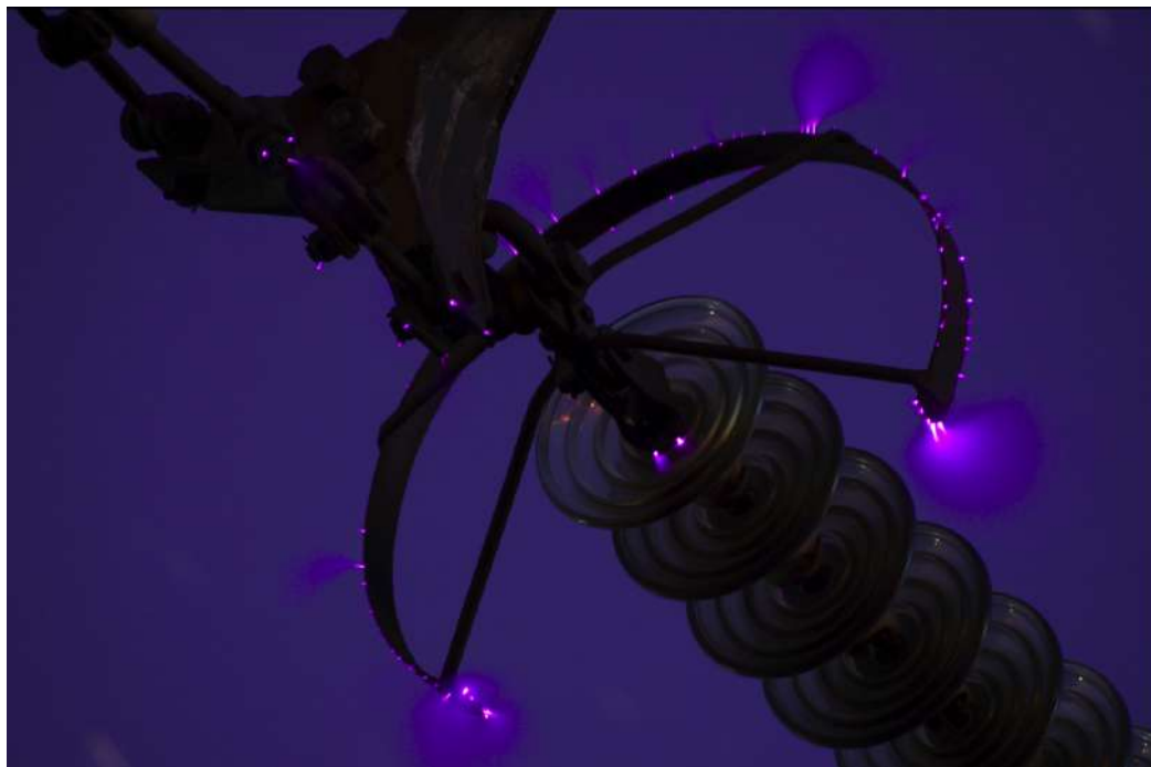
Figura 1. Anillo anticorona en una línea de 500 kV
