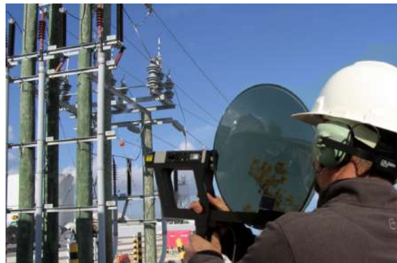
Figura 7. Detección de descargas parciales por ultrasonido
