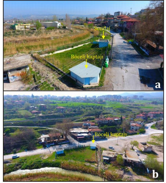
Şekil 3(a): Pınarkent Mahallesi yerleşim alanında bulunan Böceli kaynağı kaptajı ve mülga Köy Hizmetleri Denizli İl Müdürlüğü tarafından açılan sondaj (doğuya bakış). (b): Böceli kaynağı civarının genel görünümü ve içme suyu ihtiyacı fazlası suyunun verildiği çevirme kanalı.
