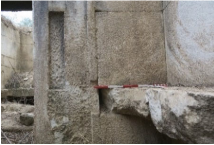
Figür 12: Ölü yatağını oluşturan yatay blok ile dikey bloğun oturacağı yuva
