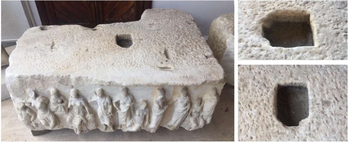
Figür 6: Tapınağın naos duvarları üzerine gelen friz bloğu ve Karia-İonia tipi kanca yuvası
