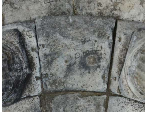
Figür 13: Görülebılır Şekilde Yapılan Kırlangıç Kuyruğu Kenet Yuvaları (Dekoratif Kenetler)
