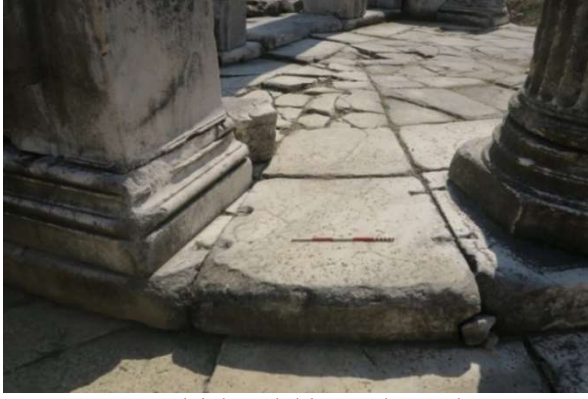
Figür 12: Görülebılır Şekilde Yapılan Kırlangıç Kuyruğu Kenet Yuvaları (Dekoratif Kenetler)
