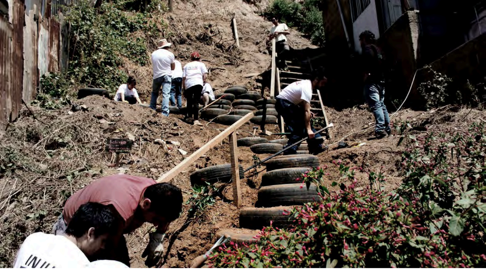
Trabajos quebrada cerro La Loma, Áncora, 2015, cortesía Áncora
