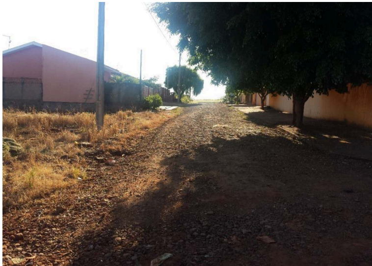
Figura 1. São Sebastião da Amoreira (PR). Ausência de asfalto, 2016
