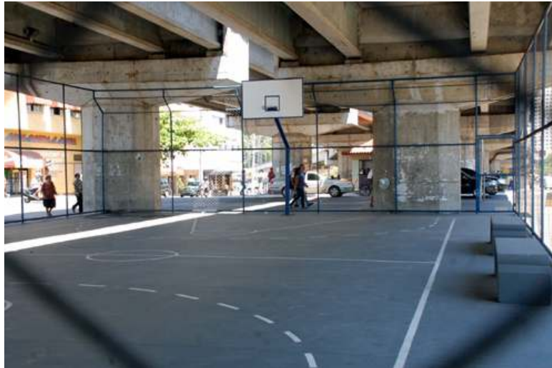
Figura 1. Viaduto da Rosinha, Centro de Campos dos Goytacazes/RJ, 2014
