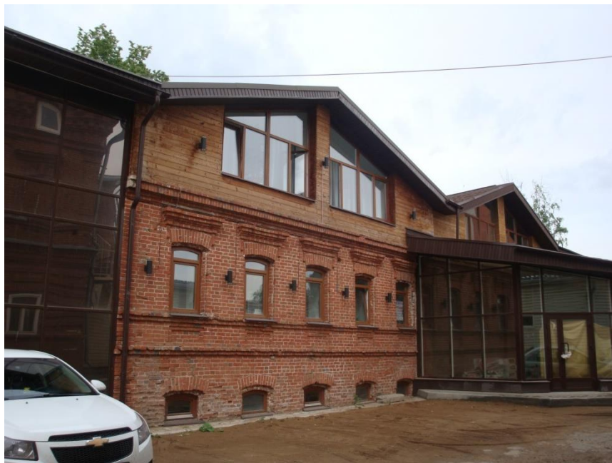
Рис. 3. Дом купца В.И. Кутузова по ул. Ленина, 3 (ранее ул. Попова). Вторая половина XIX века. Из двух зданий сохранилось только каменное, которое в 2010-е гг. было реконструировано. В советские годы здесь располагался аптечный склад. Фото автора, 2017
