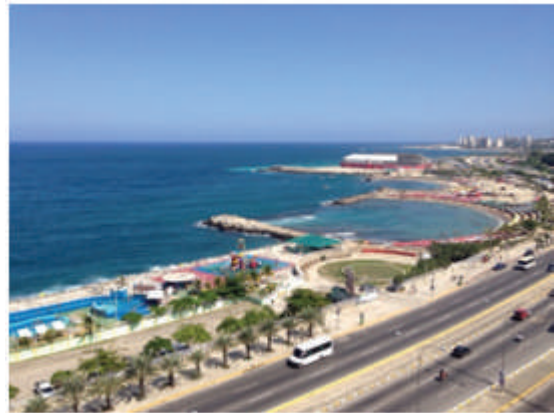
Foto N°4 Vista actual (2014) del sector de Caraballeda, cuya línea de costa fue desplazada hacia el mar
