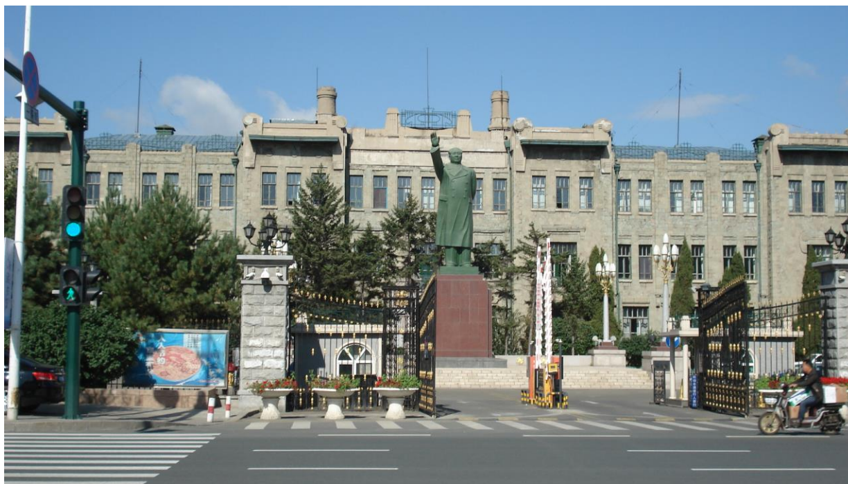
Рис. 1. Здание Управления КВЖД. Современный вид. Фото автора
