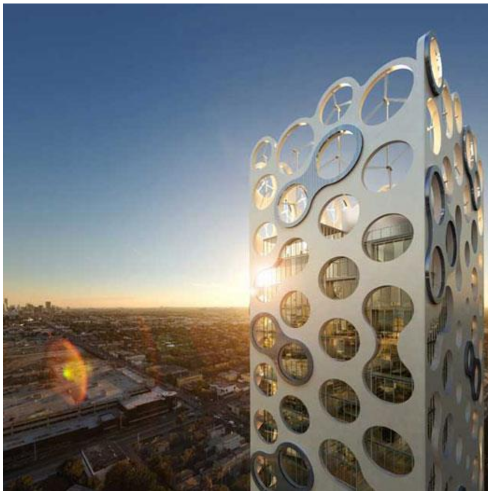
Рисунок 4 – Здание с встроенными ветроэлектрогенераторами горизонтально лопастного типа.
