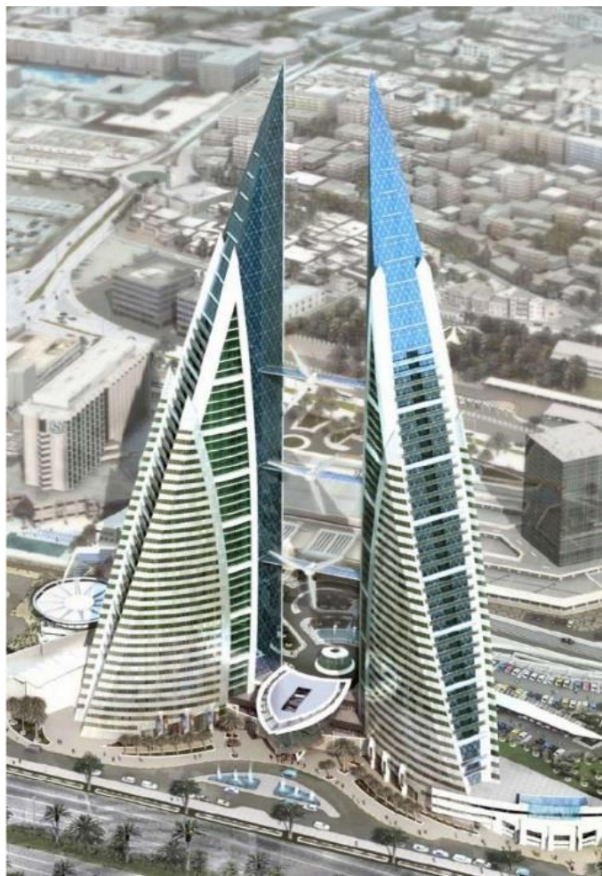
Рисунок 5 – Здание с встроенными ветроэлектрогенераторами горизонтально лопастного типа.
