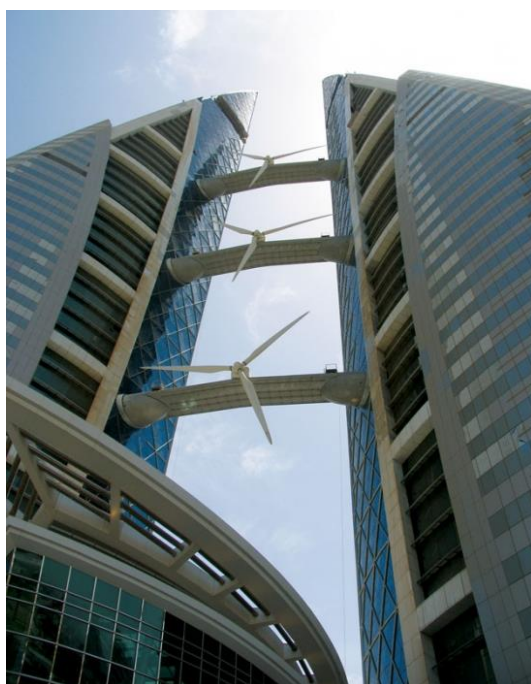
Рисунок 6 – Здание с встроенными ветроэлектрогенераторами горизонтально лопастного типа.
