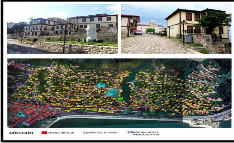
Şekil 1. Ordu Kentsel Sit Alanı Genel Görünümü (Büyükşehir Belediyesi'nden elde edilen verilerden üretilmiştir.)
