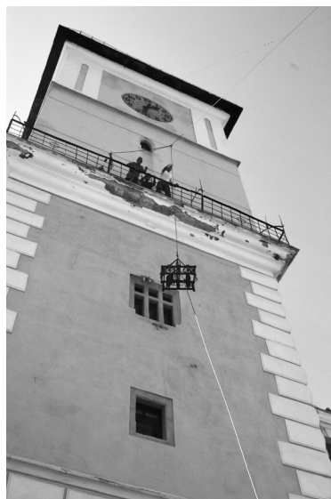
Foto 10. Ridicarea mecanismului în turn.
