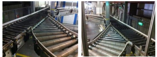
Şekil 4: Tesis içerisindeki iyileştirme bölgesi.
