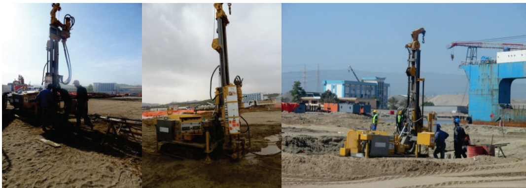
Fig. 23 – Photographies de l'essai SPT
