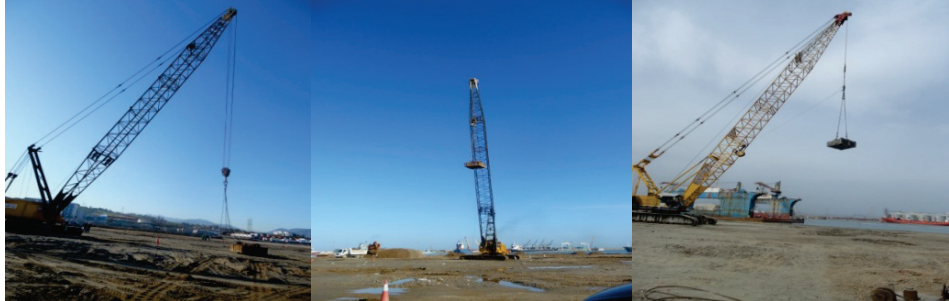
Fig. 5 –Chute libre d'une tonneuse de 20 tonnes au port de Djen-Djen Jijel-Algérie
