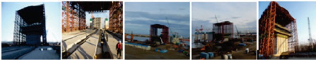
Fig. 1 – Atelier de fabrication des caissons
