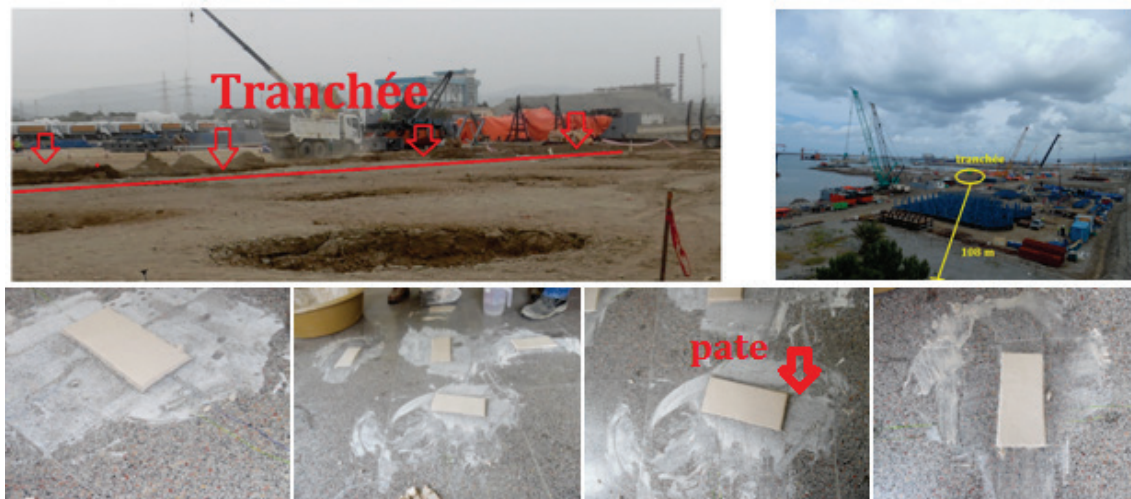
Fig. 27 – Photographies de la tranchée et la pâte
