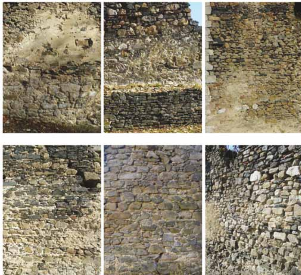
Slika 11. Primjeri faktura zidina Garića – gornji red slijeva nadesno: vanjsko pročelje južnog obrambenog zida središnje utvrde; unutarnje pročelje istočnog obrambenog zida središnje utvrde kraj sjeverne branič-kule; južno pročelje središnje kule/palasa; donji red slijeva nadesno: jugozapadno pročelje sjeverne branič-kule; vanjsko pročelje istočnoga obrambenog zida središnje utvrde; zapadno pročelje ulazne kule vanjske utvrde (Krešimir Regan, 2010.)
