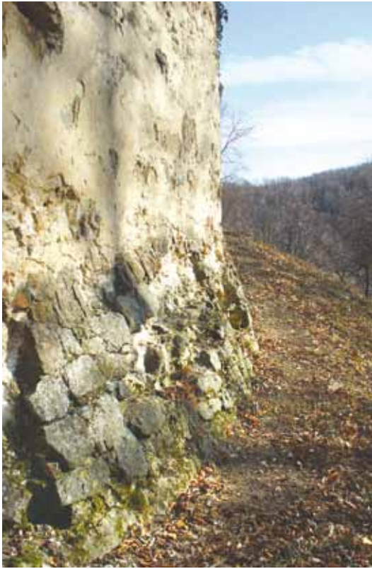
Slika 12. Skošeno podnožje vanjskog pročelja južnog obrambenog zida gledano sa zapada (Krešimir Regan, 2010.).
