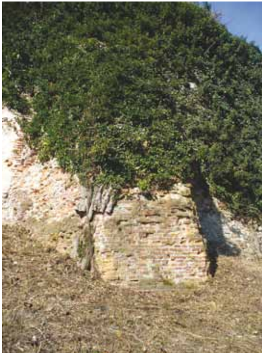
Slika 16. Masivni potpornjak od opeke naslonjen na vanjsko pročelje zapadnog obrambenog zida središnje utvrde (Krešimir Regan, 2010.)
