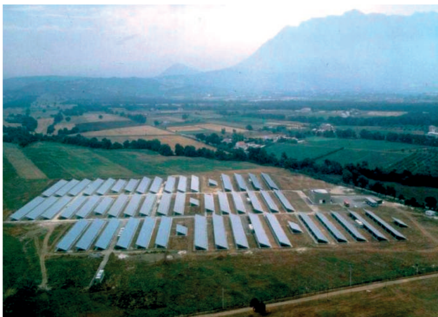
Slika 4. Solarna elektrana većeg kapaciteta
