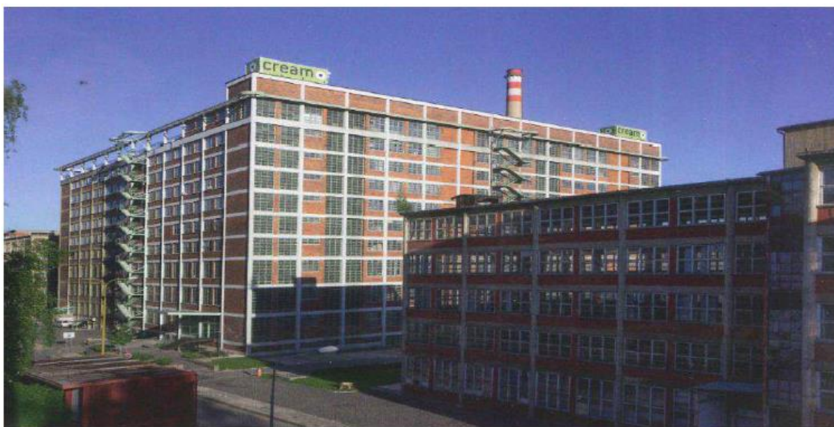
Рис. 9. Здание центрального склада (Злинская архитектура, 2013)
