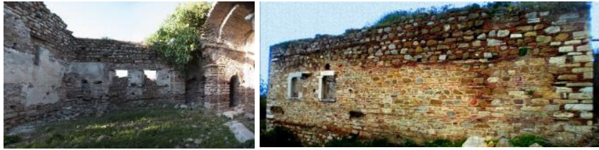
Fotođraf 26: Kilisenin Kuzey Duvar Fotođraf 27: Kilisenin Güney Cephesi
