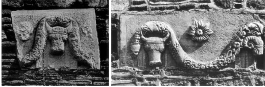
Fotoğraf 27a: Kilisenin Güney Cephesi Güneydoğu Köşedeki Lahit Parçası (Mango-Ševčenko, 1973)
