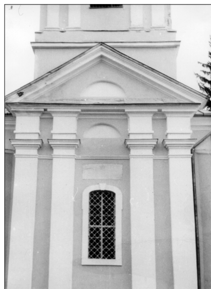
Fig. 6. Fațada de vest cu pisania bisericii Adormirea de la mănăstirea Căpriană.
