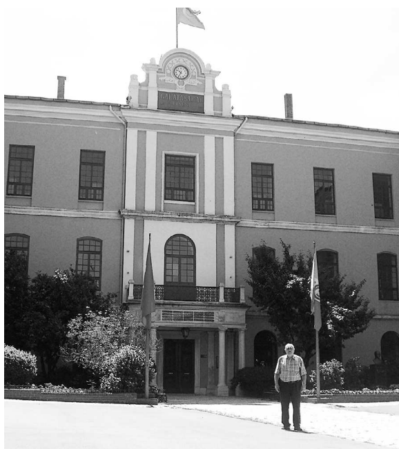
Рис. 10. Здание лицей Галатасарай. Стамбул, 2014 год.
