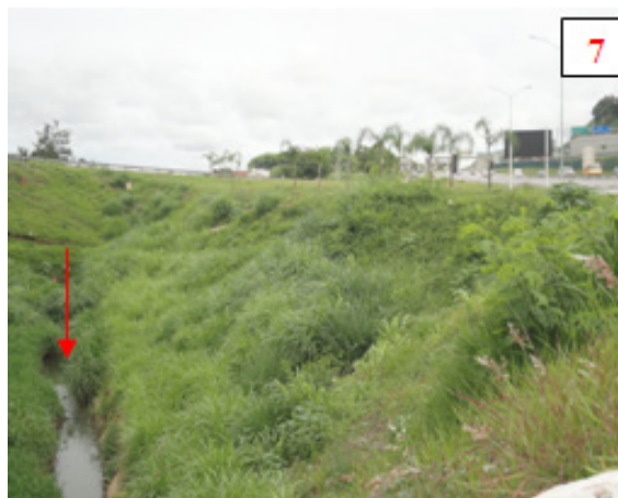
Figura 07 – Impacto esgoto a céu aberto nas margens da MG – 010.
