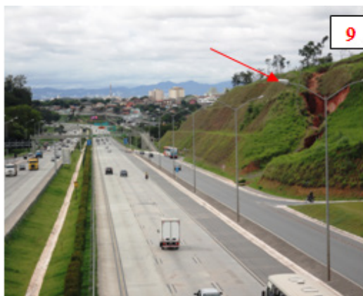
Figura 09 – Impacto Erosão na MG-010 próximo ao trevo do município de Santa Luzia (MG).
