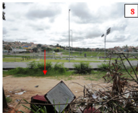
Figura 08 – Impacto resíduos sólidos descartados a céu aberto na MG-010.
