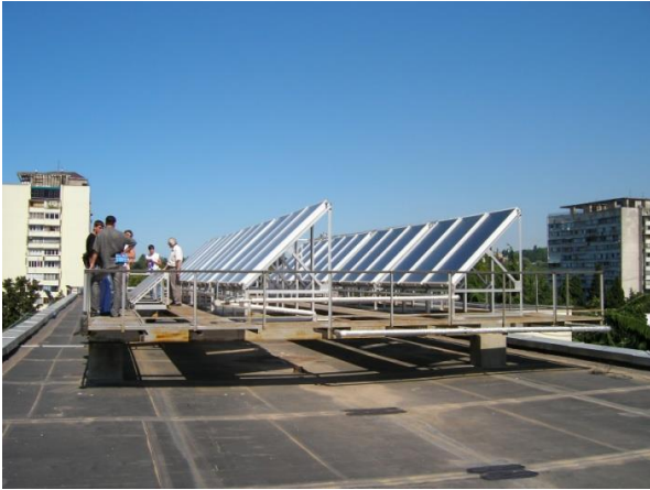
Рис. 1. Блок солнечных коллекторов Рис. 2. Баки-аккумуляторы горячей воды гелиоустановки СГУ по ул. Советской, 26-а
