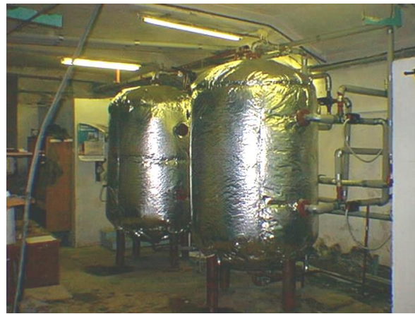
Рис. 1. Блок солнечных коллекторов Рис. 2. Баки-аккумуляторы горячей воды гелиоустановки СГУ по ул. Советской, 26-а
