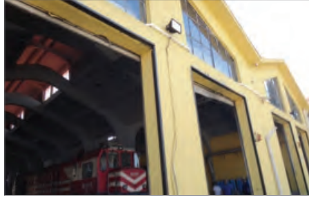
Şekil 48 Tren Bakım İstasyonu, 2013
