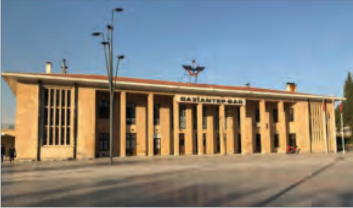
Şekil 9 Gaziantep Tren Garı güney cephesi, (Türkan Uzun, 2018)
