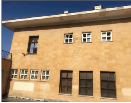
Şekil 23 Gar Binası Batı Cephe, (Merve K., 2018)
