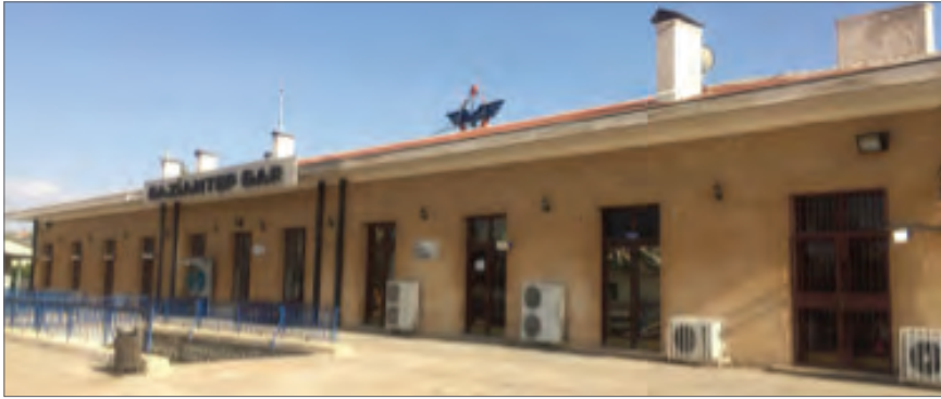
Şekil 22 Gar Binası Kuzey Cephe, (Merve K., 2018)
