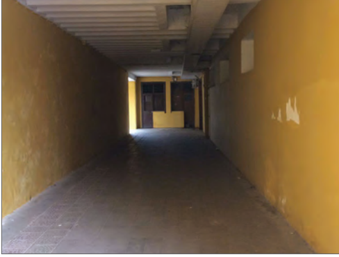
Şekil 29 Gaziantep Tren Garı Arka Bölümündeki Alt Geçit ve Nervürlü Döşeme (Merve K., 2017)
