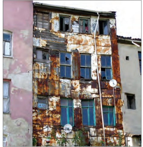
İstanbul - Balat'ta paslanmış teneke cephe kaplaması
