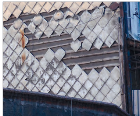
Ahşap ızgara üzerine teneke kaplama.
