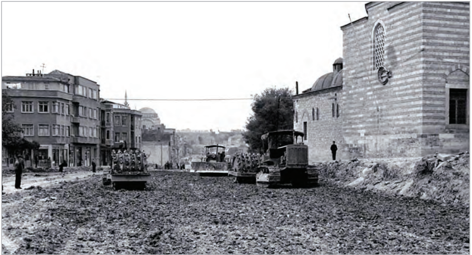
Şekil 16. Fevzipaşa Caddesi genişletme çalışmaları (Encümen Arşivi)
