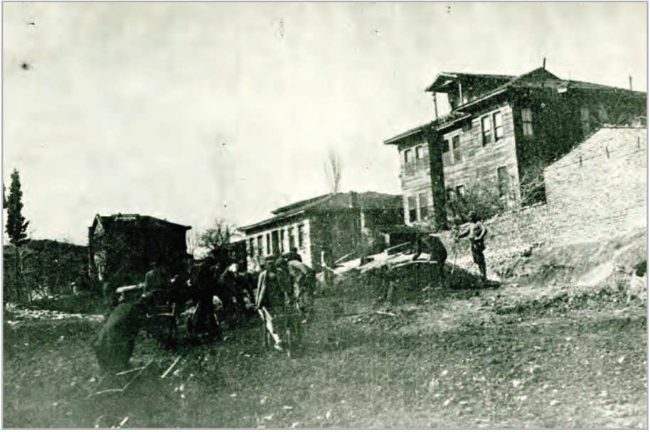
Şekil 10. Yol çalışmalarının başlangıcı (Mecmua, 1929)
