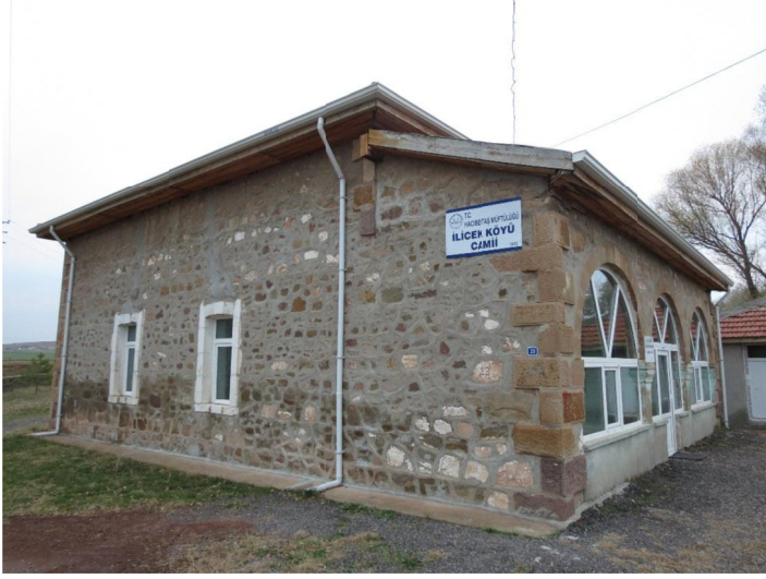
Fotoğraf 8: İlicek Köyü Kuzeydoğu Cephe
