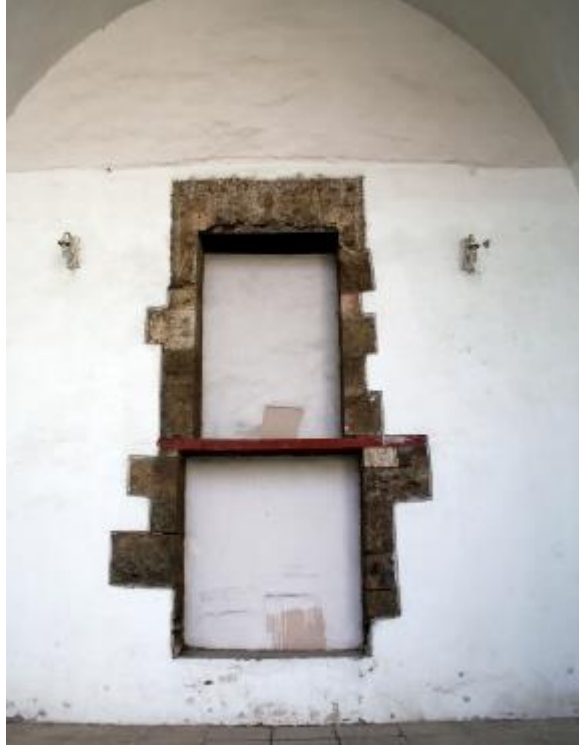
Resim 14: Ana Eyvanın Batısında Bulunan Niş
