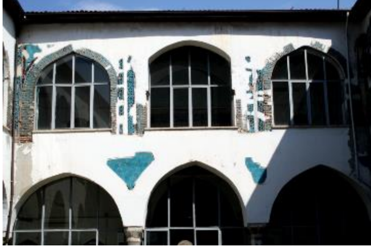
Resim 5: Avlunun Doğu Revakları
