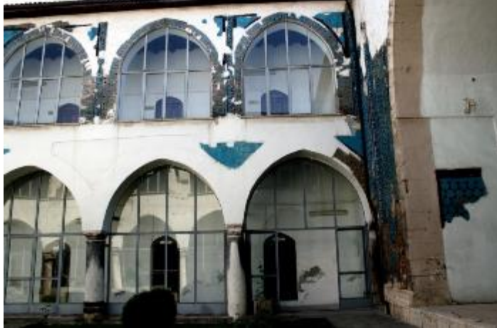
Resim 7: Avlunun Güneybatı Köşesi (Detay)
