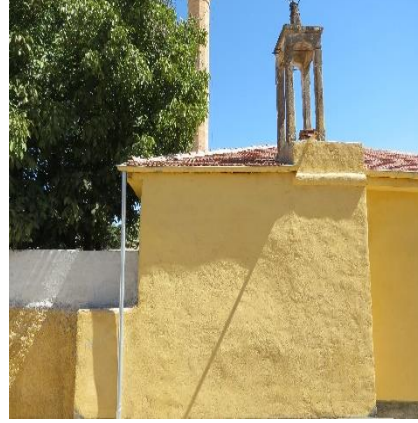
Fotoğraf 10: Kuyulutatlar Köyü Cami Köşk Minare- Kuzey Cephe
