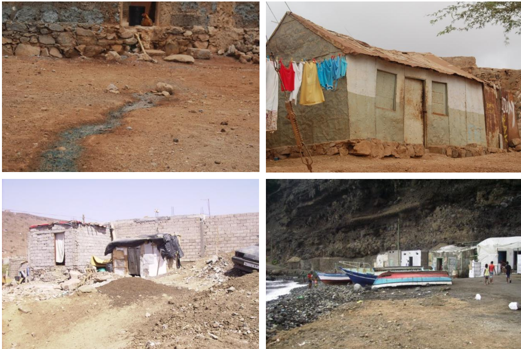
Figuras 1, 2, 3 e 4 (da esquerda para a direita) – Despejo de águas residuais no espaço público (Praia); Habitação tipo barraca em latão (Mindelo), sem segurança, sem infra-estruturas nem conforto; Habitação tipo barraca em papelão (Praia), sem segurança, sem infra-estruturas nem conforto; Grutas cavadas nas rochas que servem de habitação de algumas famílias (Santo Antão). Fonte: PENH (2010).
