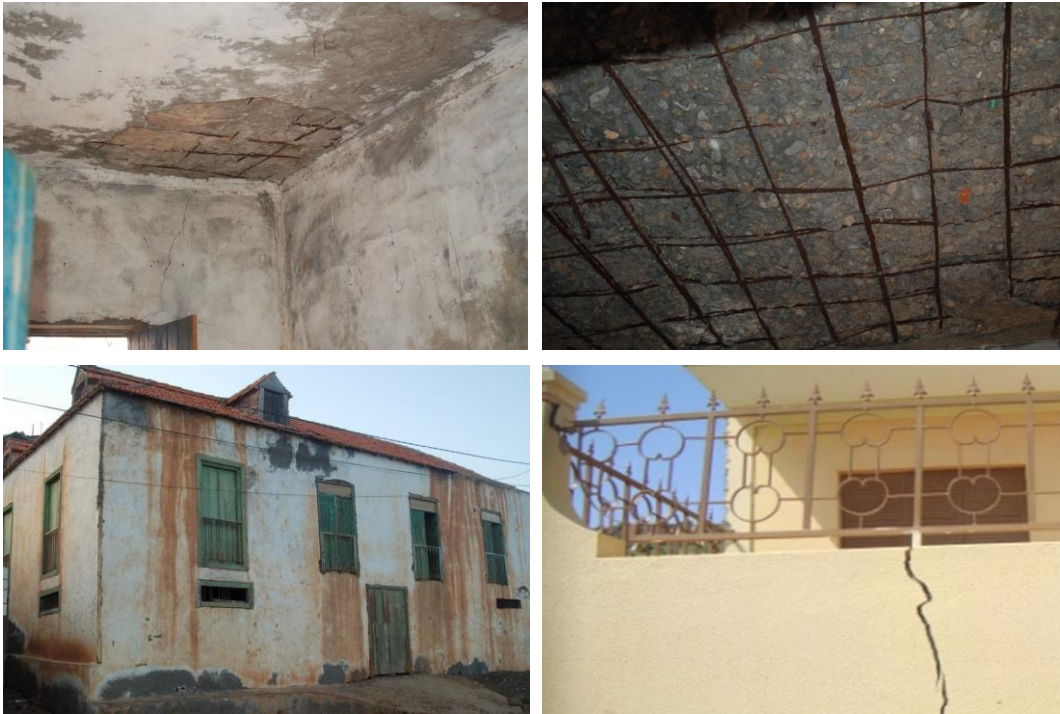
Figuras 9, 10, 11 e 12 (da esquerda para a direita) – Aspecto de tectos de residências onde se nota a contaminação do tecto como resultado da excessiva humidade e a insegurança do reboque e da estrutura de suporte do betão; Aspecto de um edifício muito antigo que representa múltiplos riscos para os residentes; Aspecto de edifícios com fissuras e que representam múltiplos riscos para os residentes. Fonte: PENH (2010).
