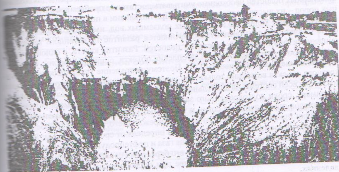
Рис. 1. Развивающийся провал над шахтой, разрабатывавшей центральную часть Солотвинского соляного купола до 1975 г.
