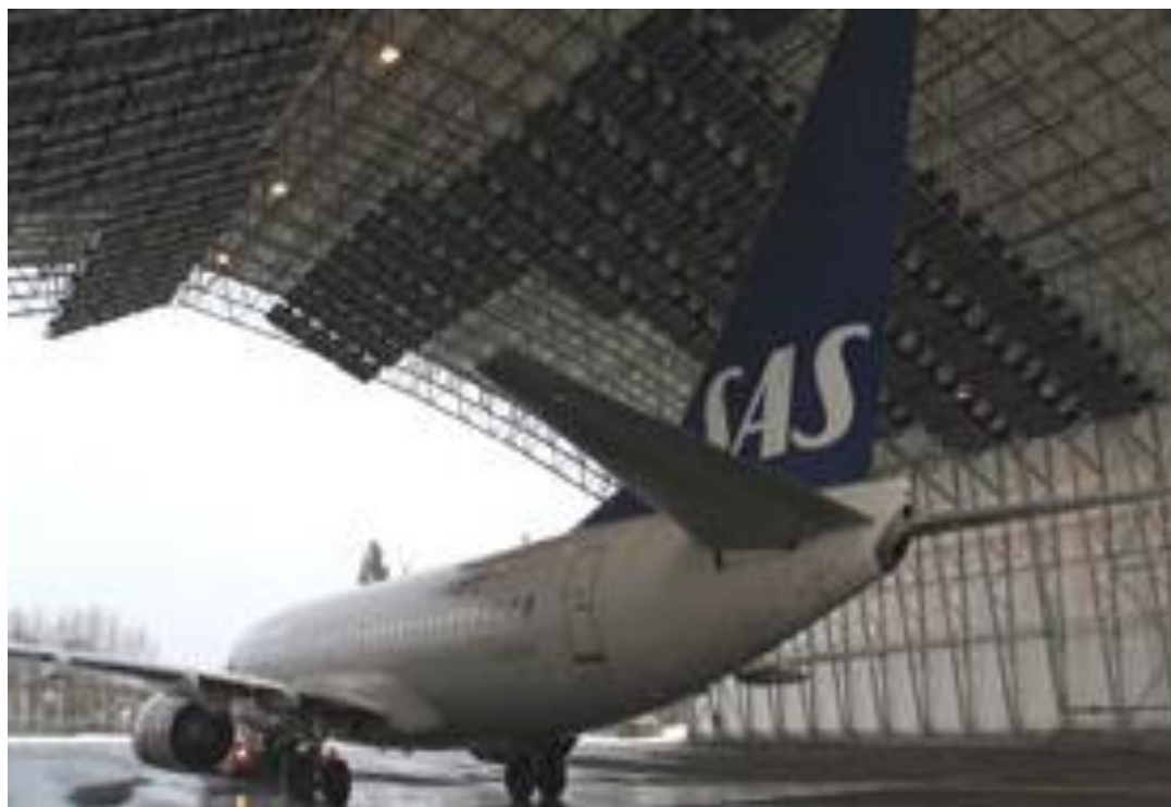
Rys. 3. Samolot podczas odladzania we wnętrzu hangaru przy użyciu promienników podczerwieni Fig. 3. An airplane in the hangar during the proces of de-icing using infrared heaters
