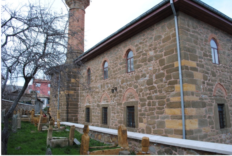
Fotoğraf 6: Yapının batı cephe görünüşü.
