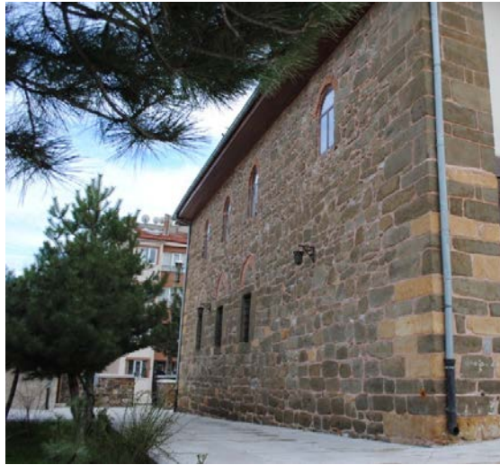
Fotoğraf 4: Yapının batı cephe görünüşü.
