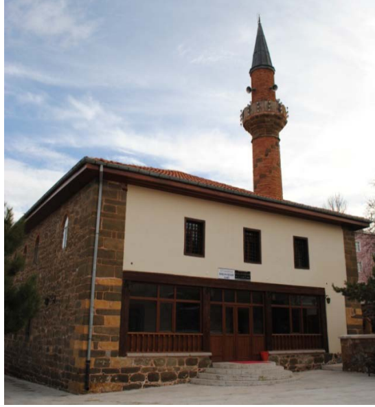
Fotoğraf 3: Yapının kuzey cephe görünüşü.
