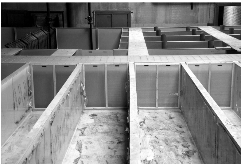
Рис. 8. Облицованные пластиком бассейны для выращивания молоди форели с использованием УЗВ в Ропше (фото В.М. Голода)
