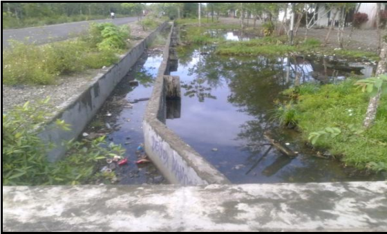
Gambar 4 Kondisi Saluran Drainase yang telah dibangun
