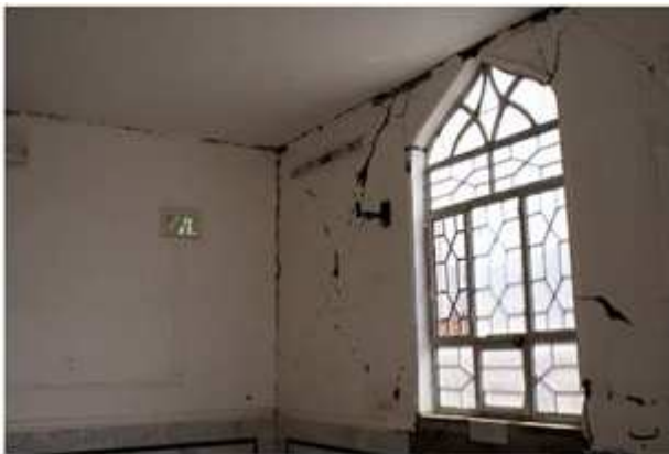
شکل ۹. خرابی بناها در اثر زمین‌لرزه سراوان، الف) خرابی بناهای ضعیف در شهر گشت و ب) ترک خوردگی گچ دیوارها در حومه شهرستان خاش، مسجد طوبی
