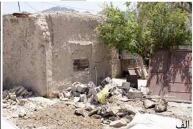
شکل ۹. خرابی بناها در اثر زمین‌لرزه سراوان، الف) خرابی بناهای ضعیف در شهر گشت و ب) ترک خوردگی گچ دیوارها در حومه شهرستان خاش، مسجد طوبی
