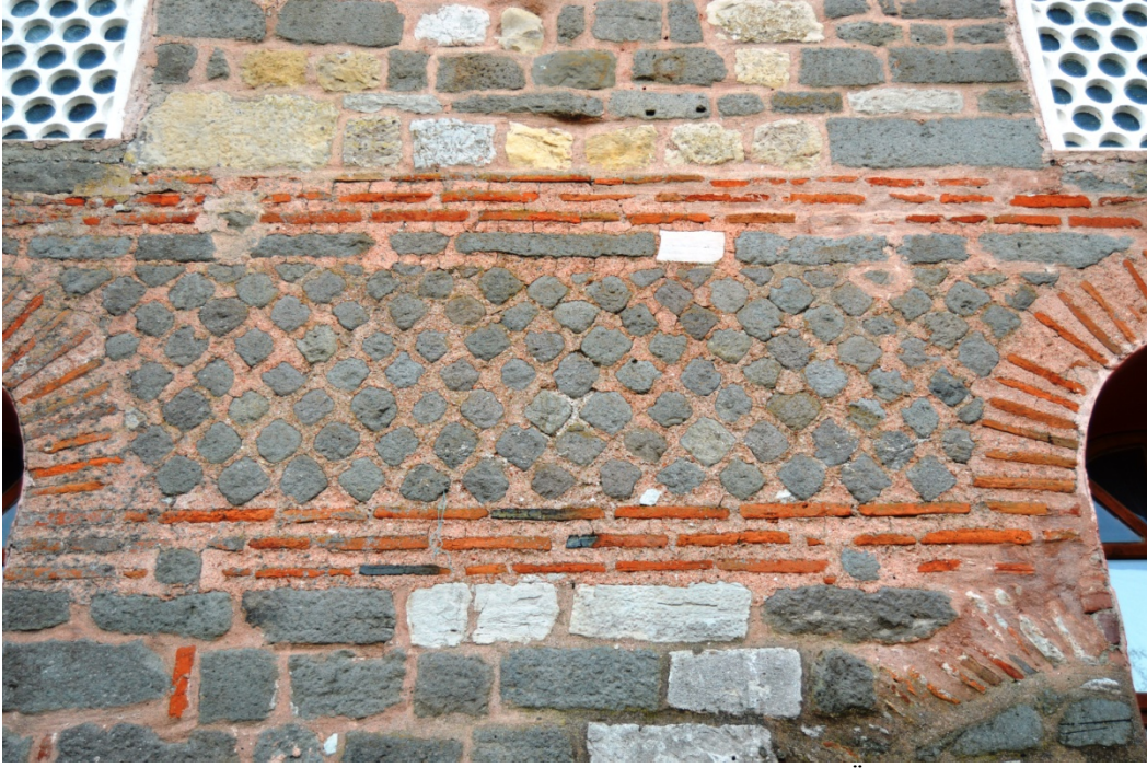
Resim 14: Kuzey Cephe, Opus Reticulatum Tekniğindeki Duvar Örgüsünden Detay
