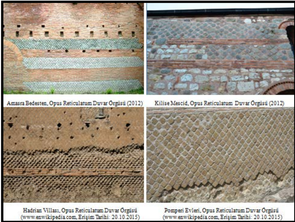
Resim 16: Opus Reticulatum Tekniğindeki Duvar Örgüsünün Görüldüğü Yapılar
