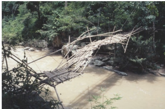
Figura 7. Puente a las afueras de Chiang Mai, Thailandia
