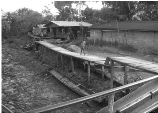
Figura 3. Puente peatonal construido por una comunidad de escasos recursos. Guapi, Cauca, 2011
