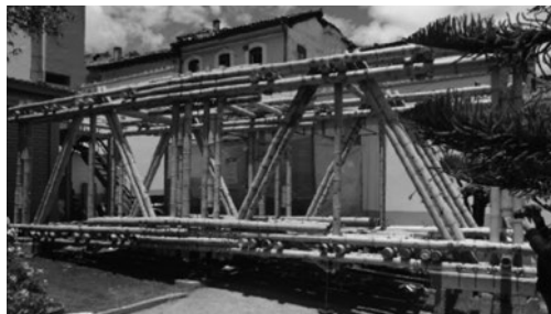
Figura 17. Prototipo de puente ensamblado a partir de dos módulos
