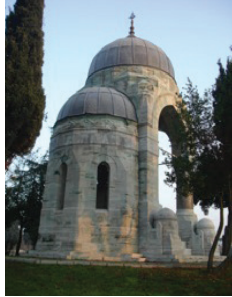
Fotoğraf 2: Mahmut Şevket Paşa Türbesi Kuzey Cephe
