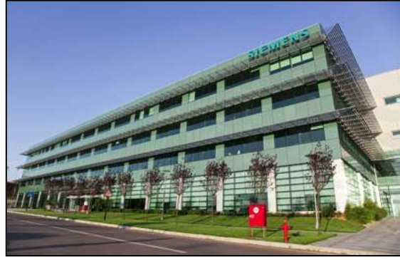
Şekil 1b: Siemens Gebze Tesisleri
