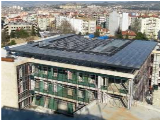
Şekil 3b: Denizli Hükümet Binası (Kaynak: www.yapinews.com)
