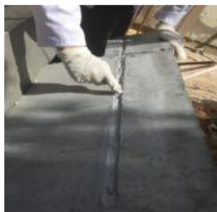
(d) Laying the 1st layer of epoxy
