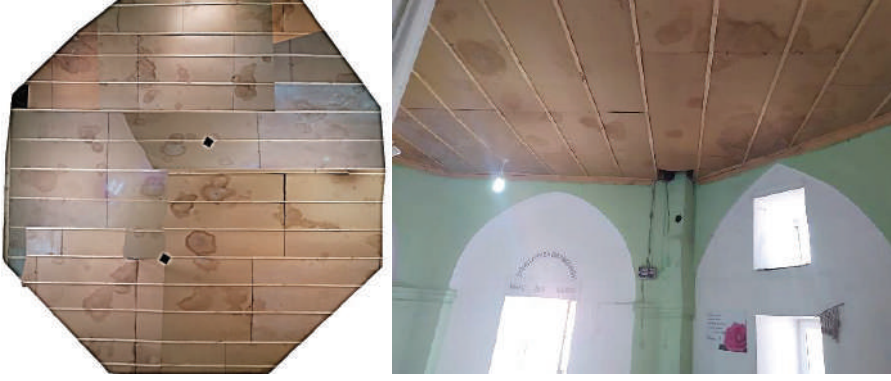
Şekil 5: İç mekândaki tavan kaplaması
