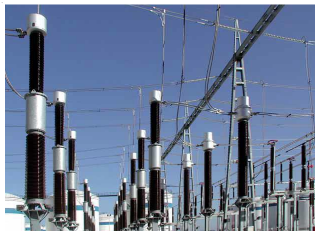
Slika 2. Induktivni naponski merni transformatori za najviši napon 420 kV [6]
