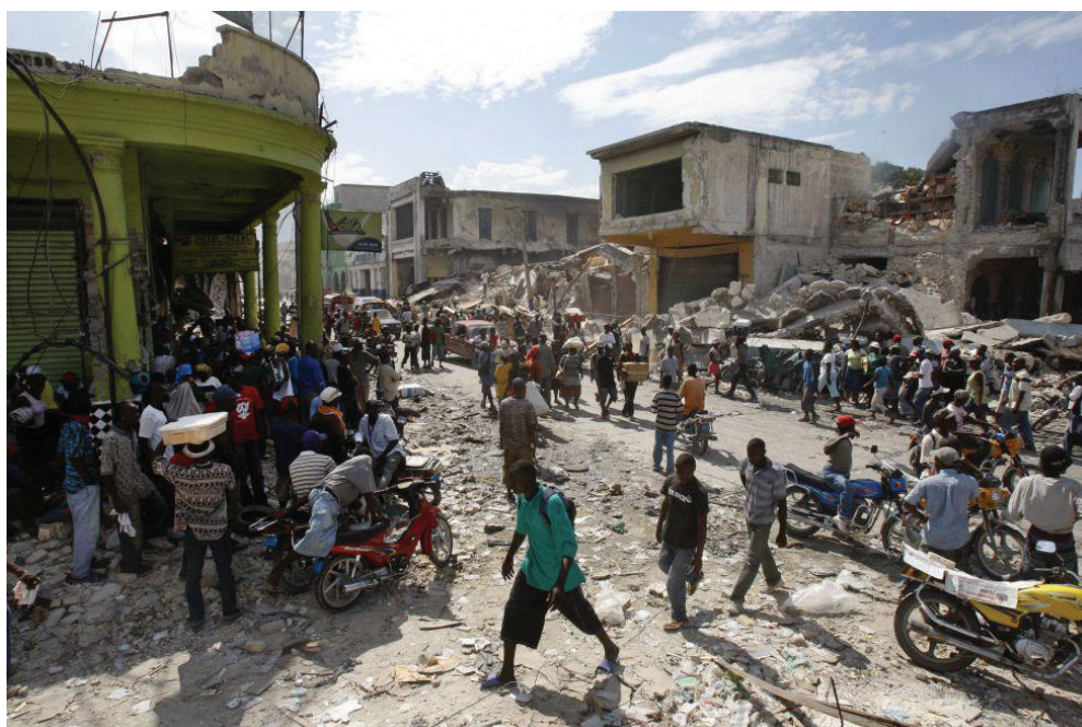
Figura 2. Rua de Porto Príncipe após terremoto de 2010 (SÁNCHEZ; LEJARCEGI, 2014).
