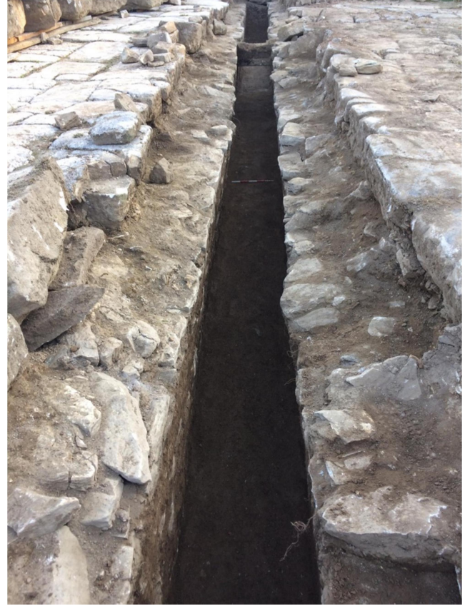
Figür 3: Kuzey Cadde kanalizasyonunun temizlenmiş hali
